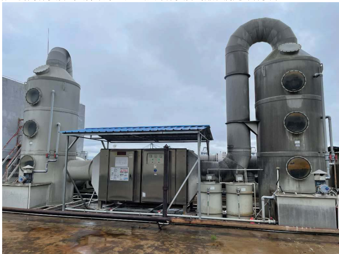
图 4-5 罐区废气催化氧化+吸收塔照片
