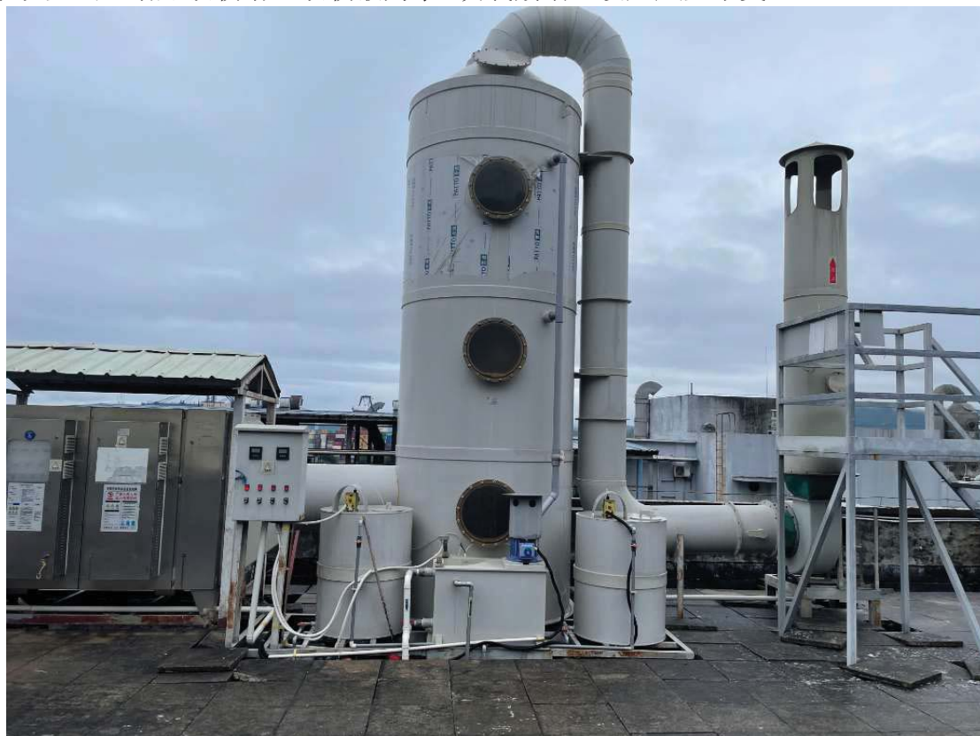
图 4-7 废水处理站臭气 UV 光解+吸收塔照片
