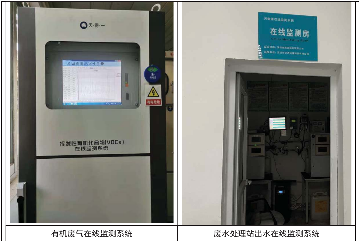
图4-11 在线监测系统照片
